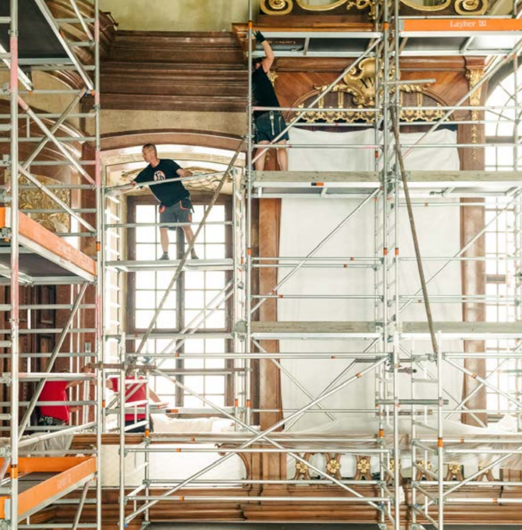
Die Restaurierung des Prunksaals ist in vollem Gang
