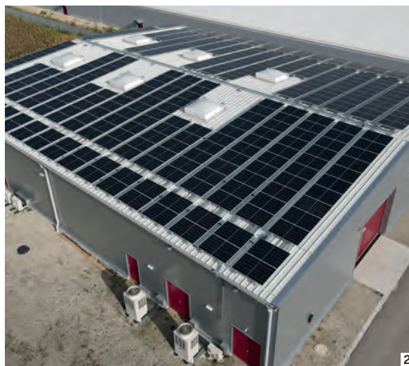
2 Die neue Photovoltaik-Anlage am Dach des externen Depots in Haringsee
