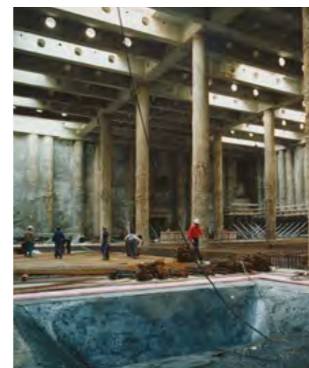
Bauarbeiten für den Bücherspeicher neben dem Burggarten, ca. 1989
