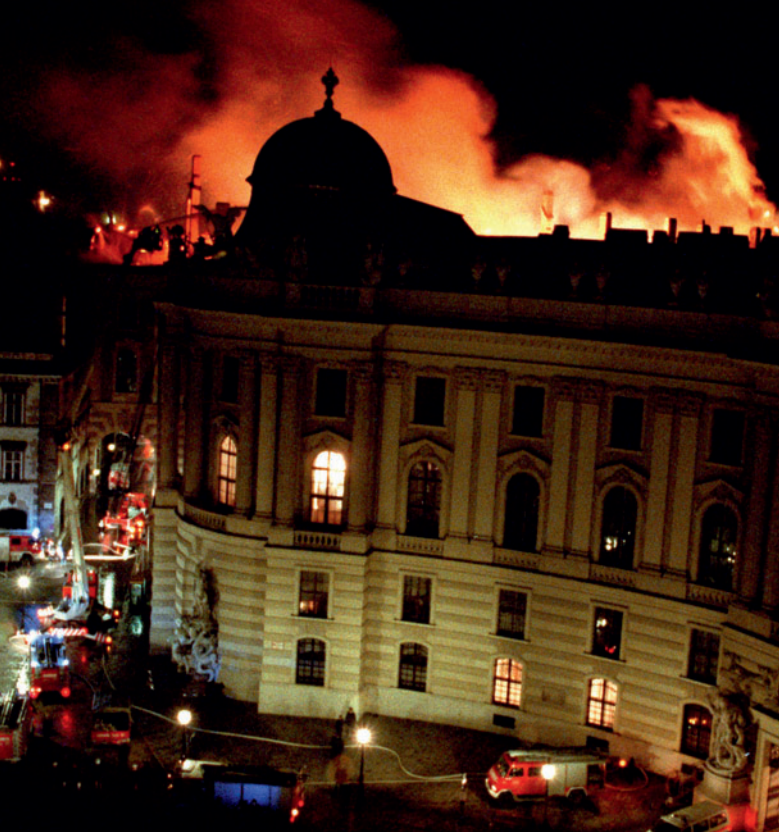
In der Nacht vom 26. auf den 27. November 1992 brannten Teile der Wiener Hofburg.
