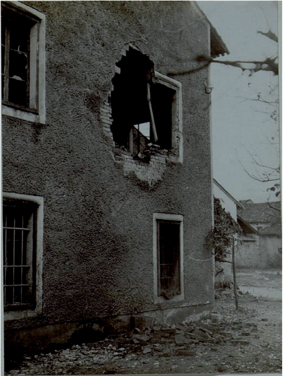
Abb. 9: Granatloch in einem Gebäude November 1916 (© ÖNB, Bildarchiv, WK1/ALB004/00929)
