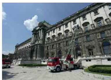
Räumungsübung bei Vollbetrieb ...
