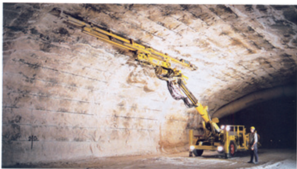
Halbautomatischer Bohrwagen mit Parallelführung, Zielpunkt- und Abstandsautomatik zur Herstellung der Sprengbohrlöcher
