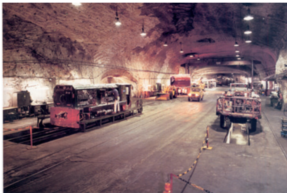
Blick in die Hauptwerkstatt auf der 940 m-Sohle
