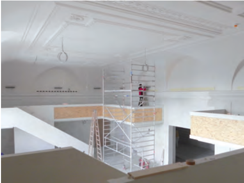
Umbauarbeiten zur Einrichtung des Ludwig-Wittgenstein-Forschungslesesaals, Stand Ende 2011
